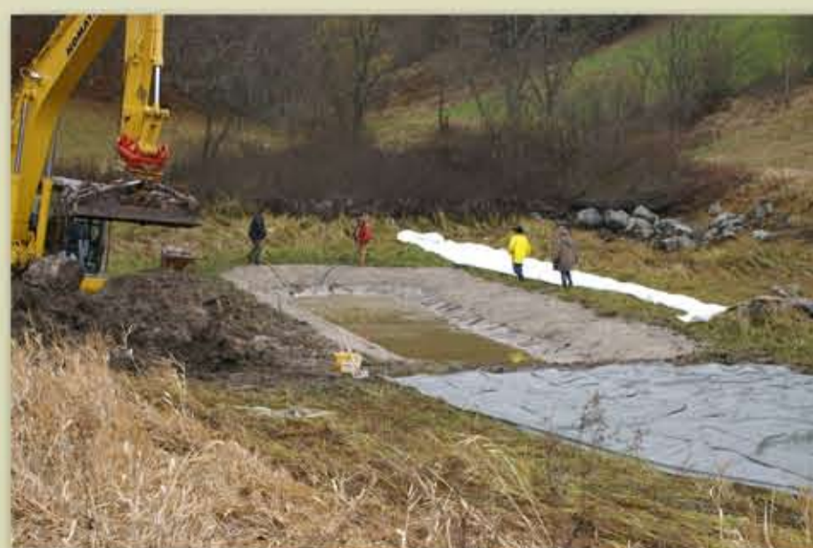
Um das vollständige Austrocknen zu verhindern, wurde in einem Teilbereich eine Folie eingebaut.
