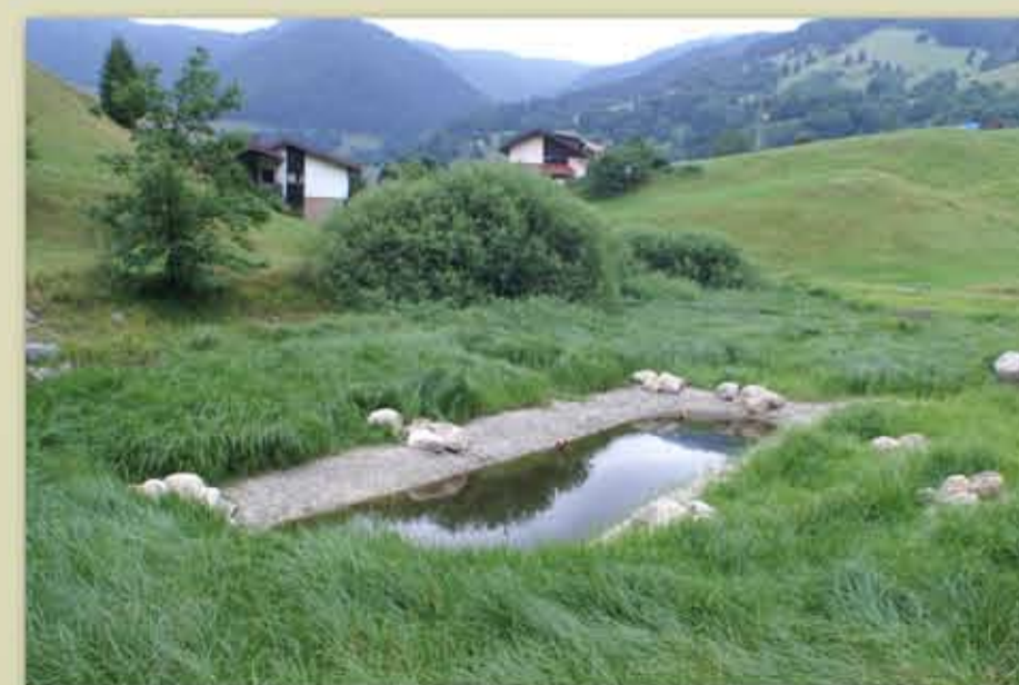
Große Steine beschweren die abgedeckten Folienränder und verhindern dadurch deren Abrutschen.
